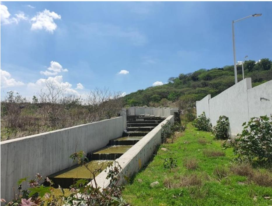
*Canal que conduce los volúmenes excedentes de agua residual tratada y de agua de lluvia*
